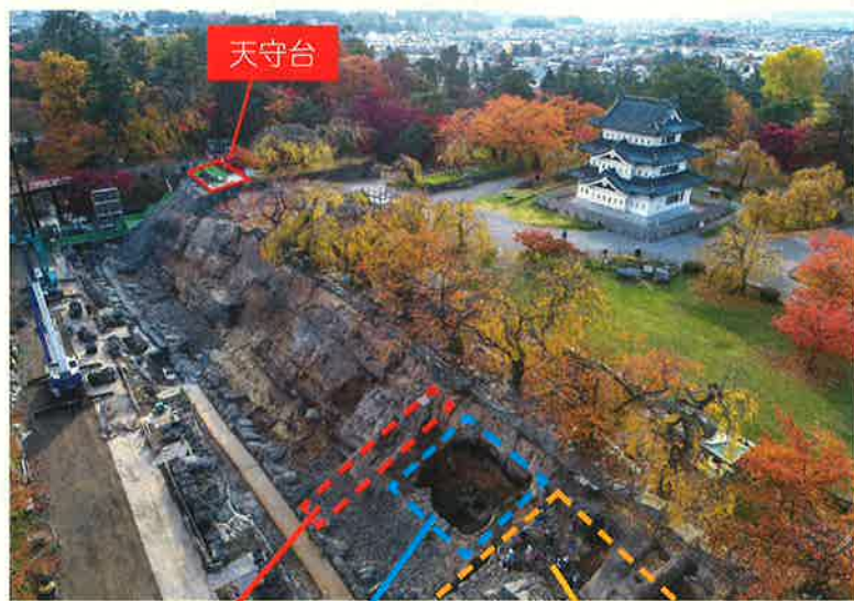
▲石垣の出角・井戸跡・排水跡の位置（北東から撮影）
