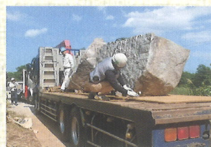
(※4) 粗割りした石材の運搬
