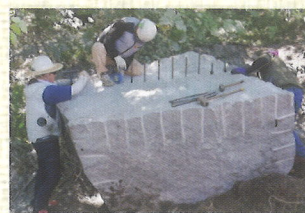
(※3) 調達した石材の粗割り作業
