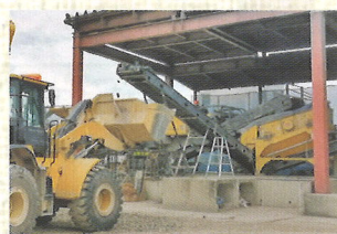
(※7) 破砕機で角礫に加工
