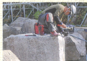
(※5) 交換石の仕上げ加工
