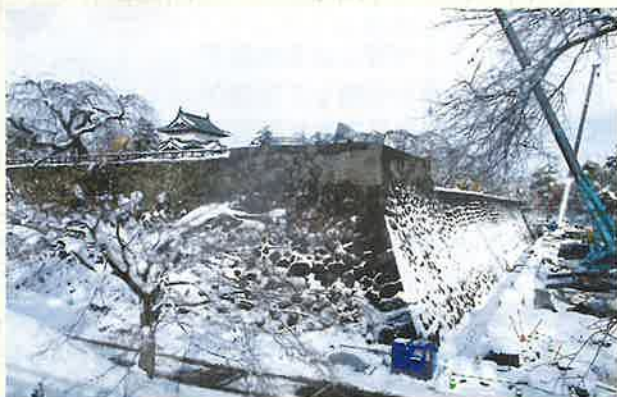
▲（※1）天守台石垣積み直し完了（令和 6 年 12 月）
