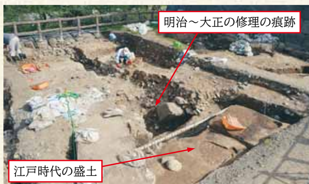
△発掘調査で確認された、明治～大正の石垣修理の痕跡
