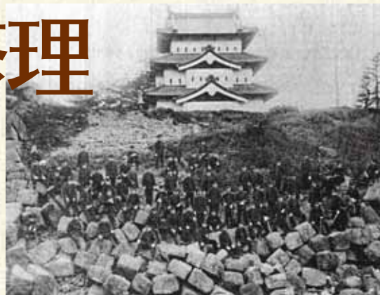
△明治29年以降の石垣崩壊（弘前図書館所蔵） 天守が西側に曳屋されているのが分かる。
