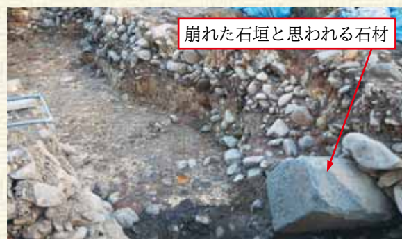
△明治～大正時代に石垣崩落部分を修復した盛土
